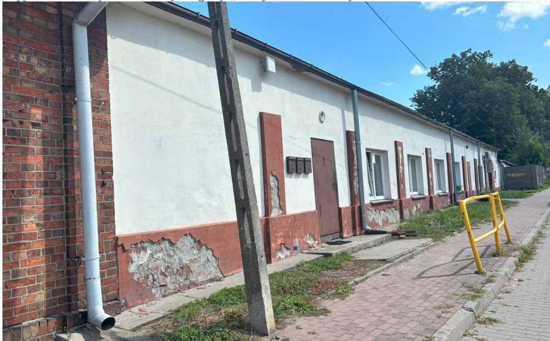
Zdjęcie 11 Turczynek – dawny magazyn, budynek komunalny
